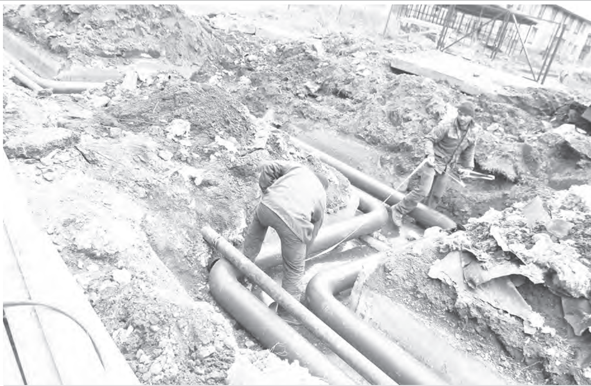
Ремонт теплотрассы на улице Стадионной. Рабочие замеряют погонные метры трубопровода
