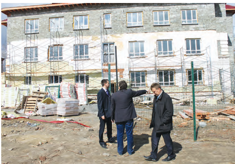
Глава района и глава города осмотрели все помещения строящегося детского сада №6, оценили темпы и качество выполненных работ, а также отделочных материалов
