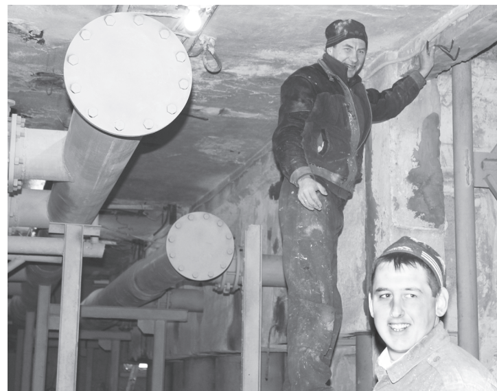
Рабочие осуществляют монтаж проводки электрофильтровальной станции
