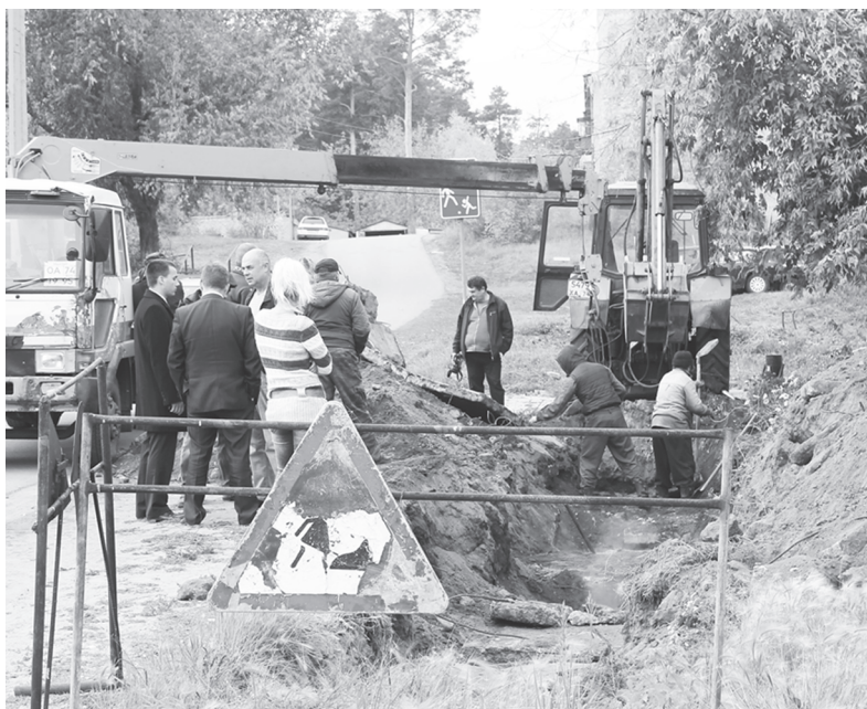
Ремонт в системе горячего водоснабжения на улице Лобашова
