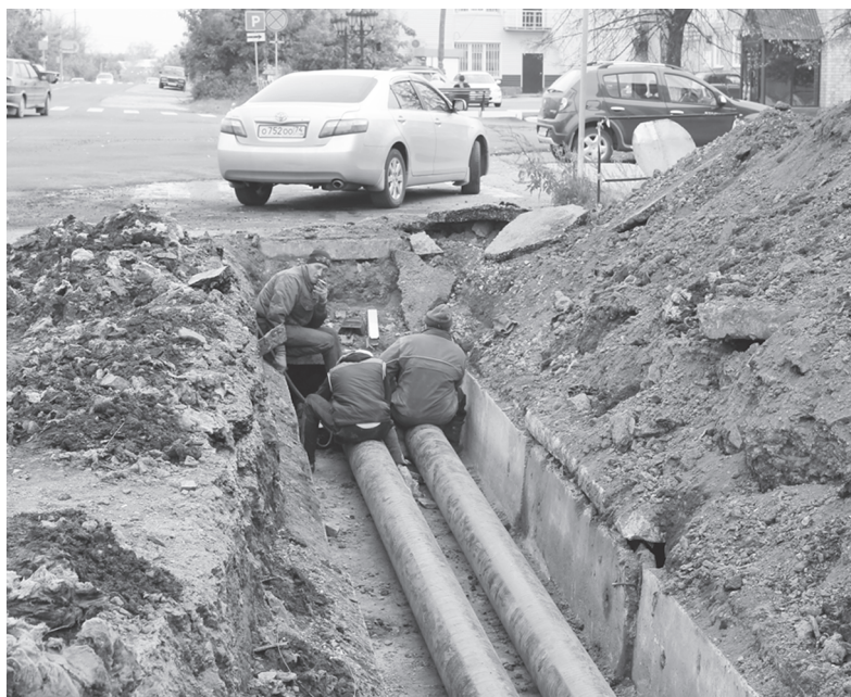
Замена труб на теплотрассе по улице Ленина около ОАО «Радий»
