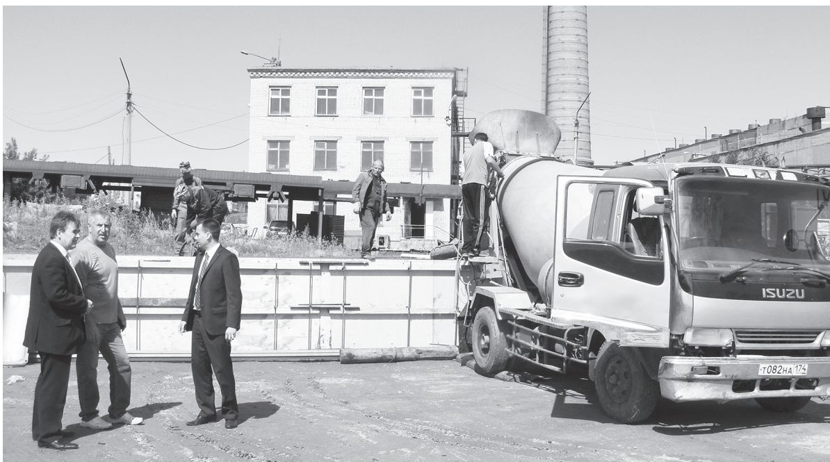
Юрий Скулыбердин, Сергей Сычев, руководитель подрядной организации ООО «Промгражданстрой», и Александр Грачев на строительной площадке, где идет заливка фундамента под когенерационную установку
