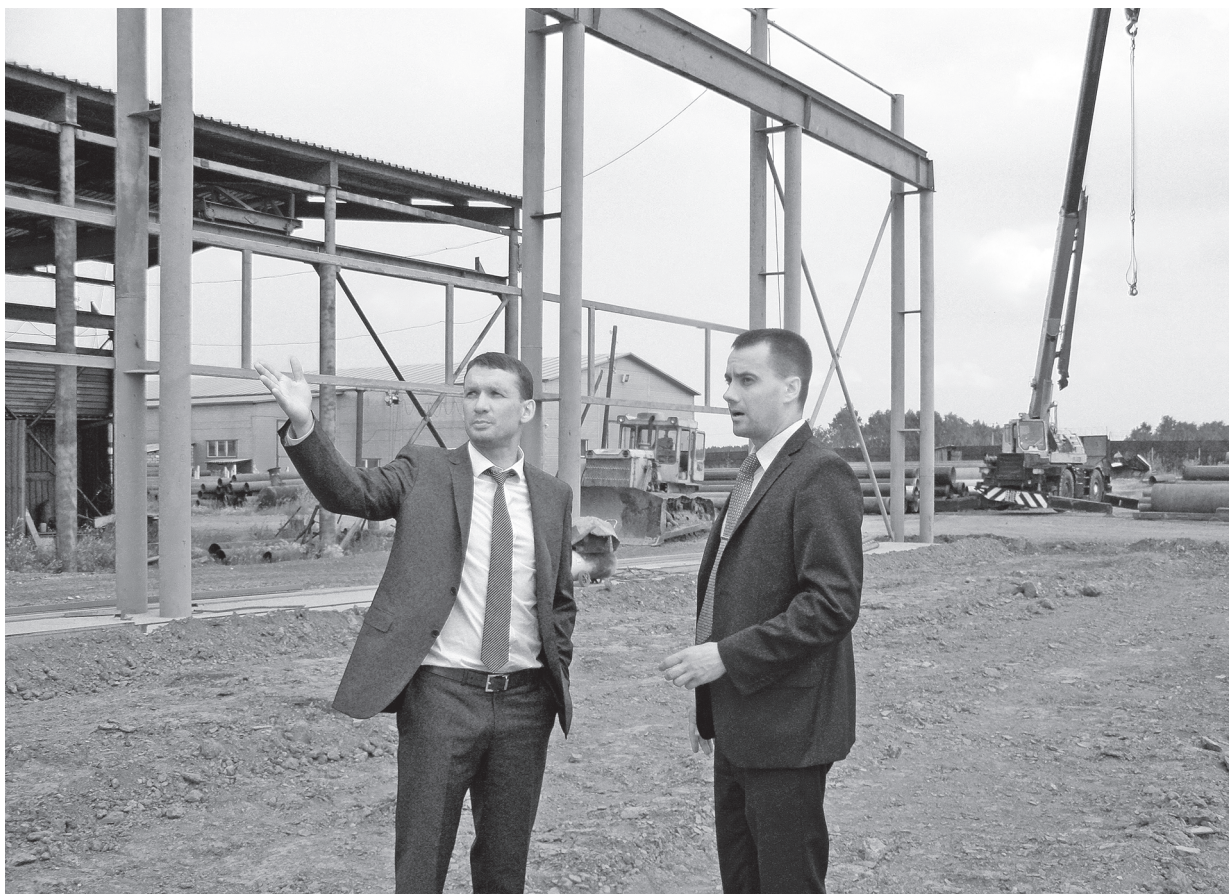
Александр Каптюг и Александр Грачев на строительной площадке, где уже возведен несущий каркас будущего механического предприятия по производству нестандартных металлоконструкций
