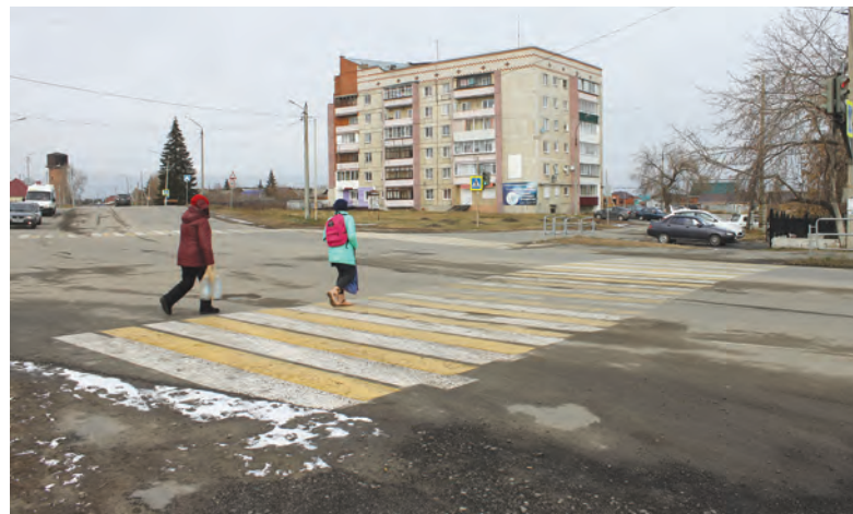
На пешеходном переходе по улице Ленина у здания ДШИ отсутствуют знак «Дети», мигающий светофор, разметка 2.7 и ограждение с одной стороны
