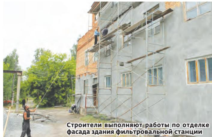
Строители выполняют работы по отделке фасада здания фильтровальной станции
