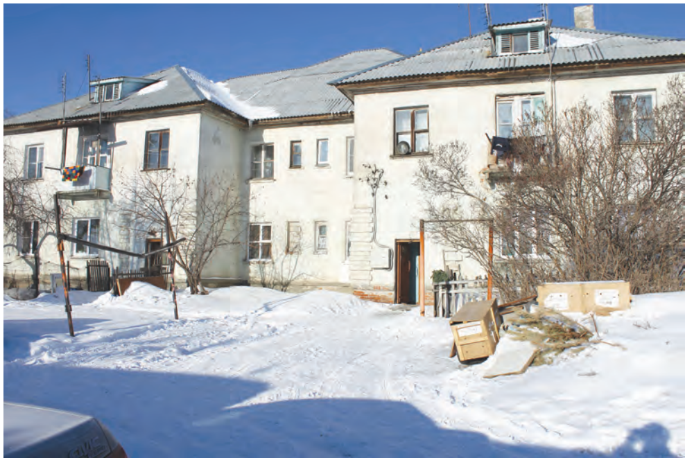
Капитальный ремонт дома №81 на ул. Свердлова в Каслях запланирован на этот год
