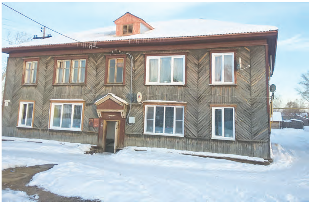
Жилой дом №13 на улице Суворова в п. Береговой с капитально отремонтированной крышей
