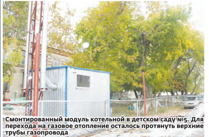
Смонтированный модуль котельной в детском саду №5. Для перехода на газовое отопление осталось протянуть верхние трубы газопровода
