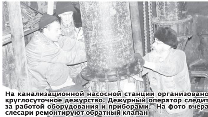
На канализационной насосной станции организовано круглосуточное дежурство. Дежурный оператор следит за работой оборудования и приборами. На фото вчера слесари ремонтируют обратный клапан
