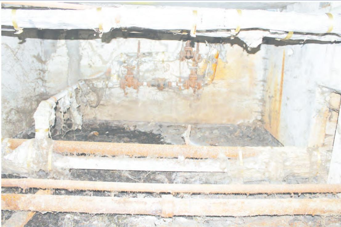
На трубах отопления отсутствует теплоизоляция, что является нарушением нормативных требований и без чего обогрев дома становится неэффективным
