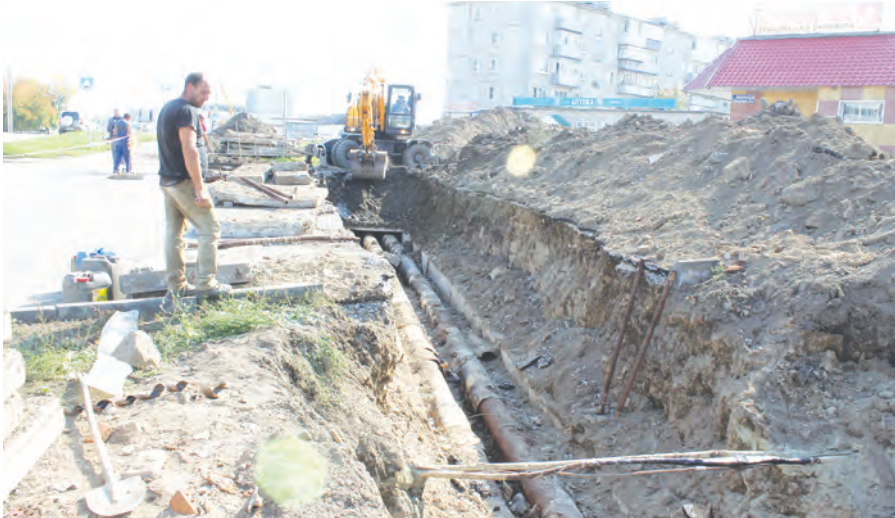
На теплотрассе по улице Ленина готовят участок к замене старых труб на новые
