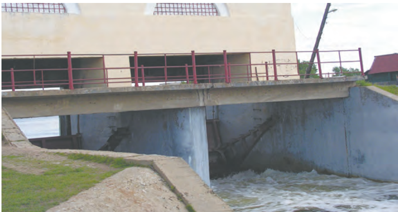
Шлюз для сброса воды в районе улиц Пролетарской и Заветы Ильича в г. Касли обслуживается ПО «Маяк»
