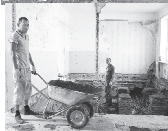
Рабочие подрядной организации ООО «Стройком-плюс» приводят в порядок помещение детского сада
